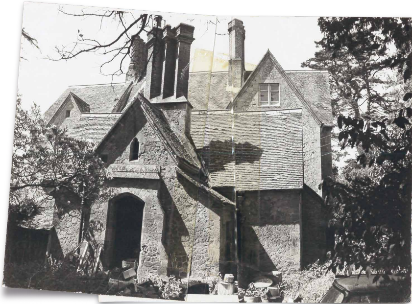
ประตูทางเข้าเดิมด้านข้างบ้าน เป็นทางเข้าไปห้องครัว ห้องเก็บอาหาร บันไดลงบ้าน ห้องน้ำ และชั้นใต้ดินซึ่งพบร่องรอยของฟอสฟอรัสก่อนหน้านั้น เมื่อมองกว้าง
